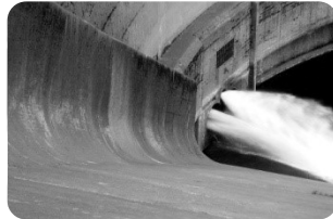
Barrage de Palisse ©BETCGB
